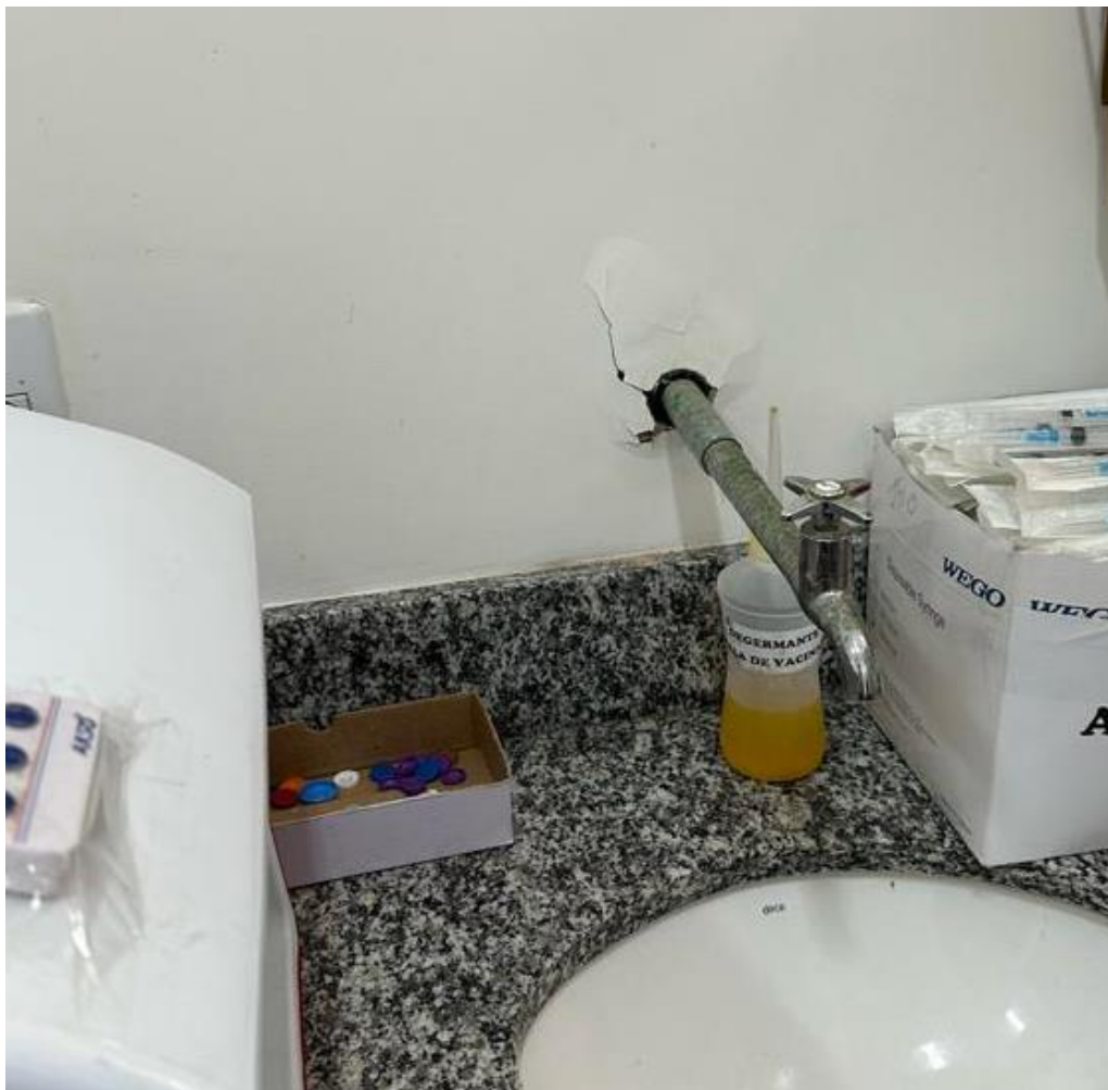
Figura 7 – Parede com desgaste no acabamento ao redor da instalação da torneira.
